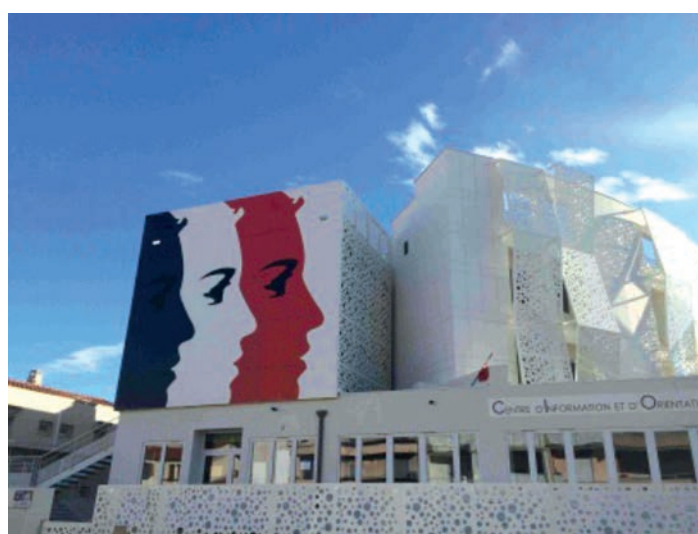
Rénovation énergétique – DSDEN 66
